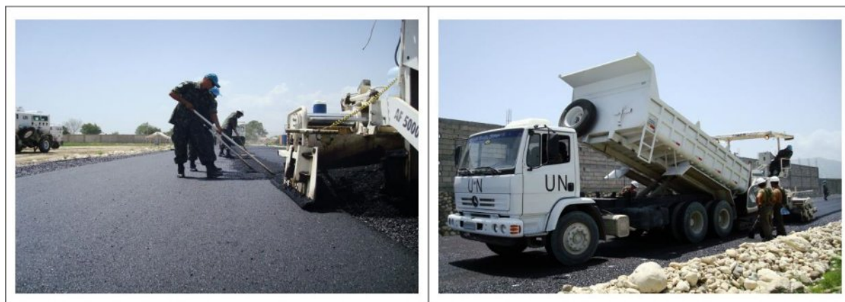
Figura 3: Preparação da via para pavimentação com agregado de calcário
