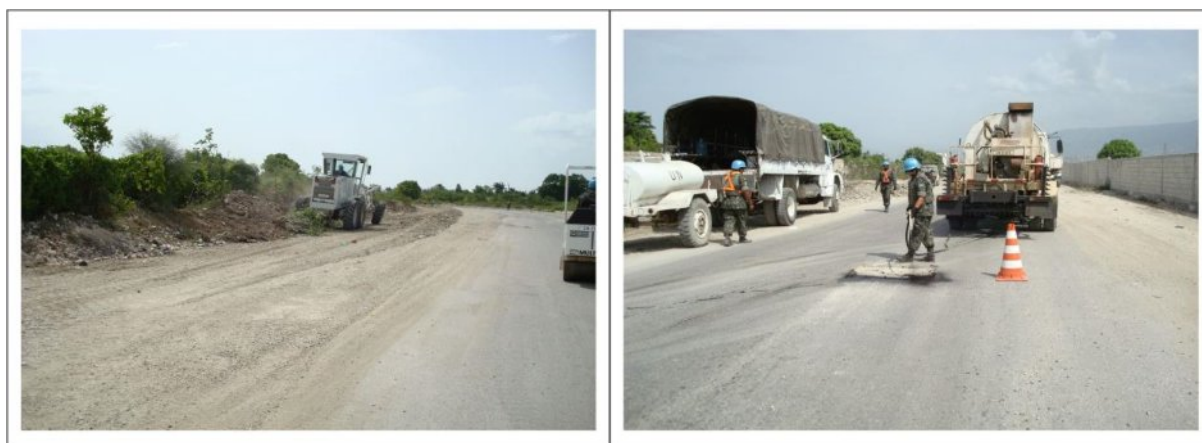
Figura 2: Preparação da via para pavimentação com agregado de calcário
